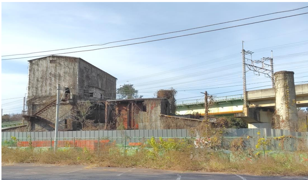
2021年12月の清柳園、後方は武蔵野線高架橋
